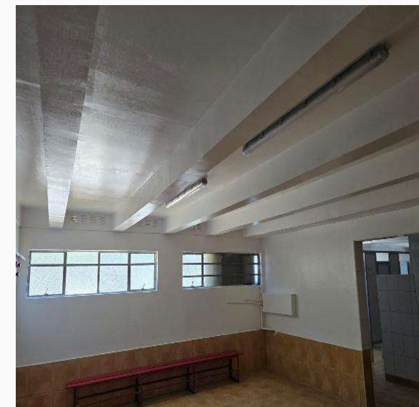
Reparación Provisoria cielos camarines gimnasio
